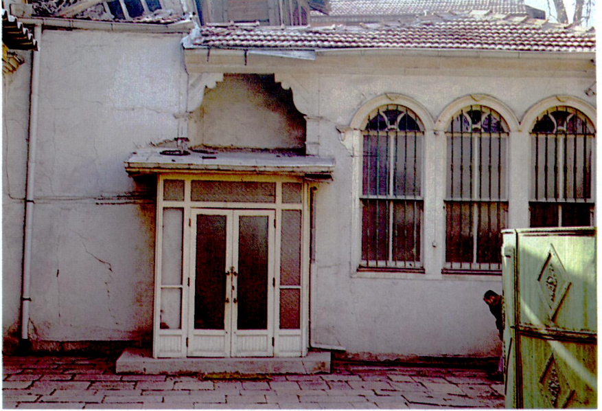
Res. 16 – Sinagog kapısı. Door of the Synagogue.
