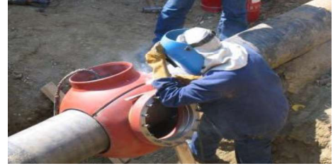
Şekil 1. Çelik doğalgaz hattı branşman bağlantısı için hot-tap bağlantı kaynağı [url-1].
