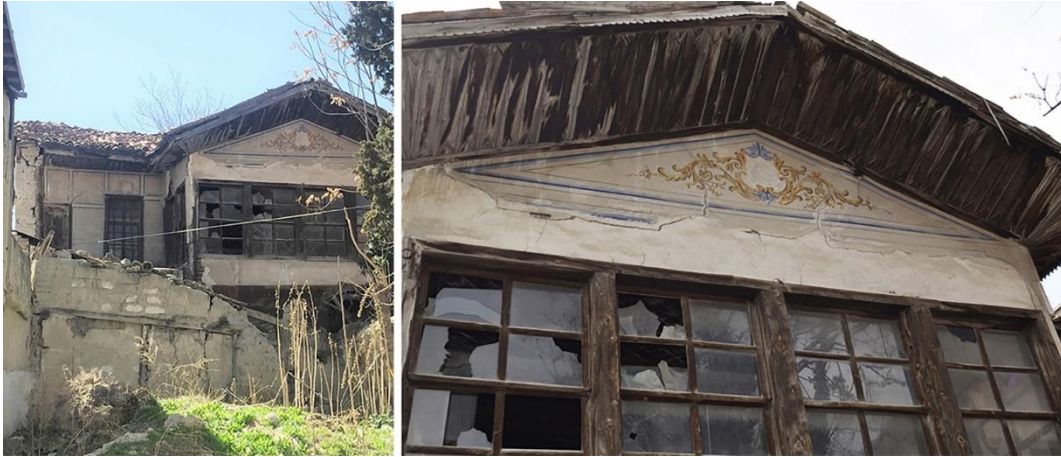
Şekil 17. Kuzey cephesi kütle hareketi ve kalem işi bezemeleri (Kaynak: Esra Büyükemir Karagöz kişisel arşivi).
