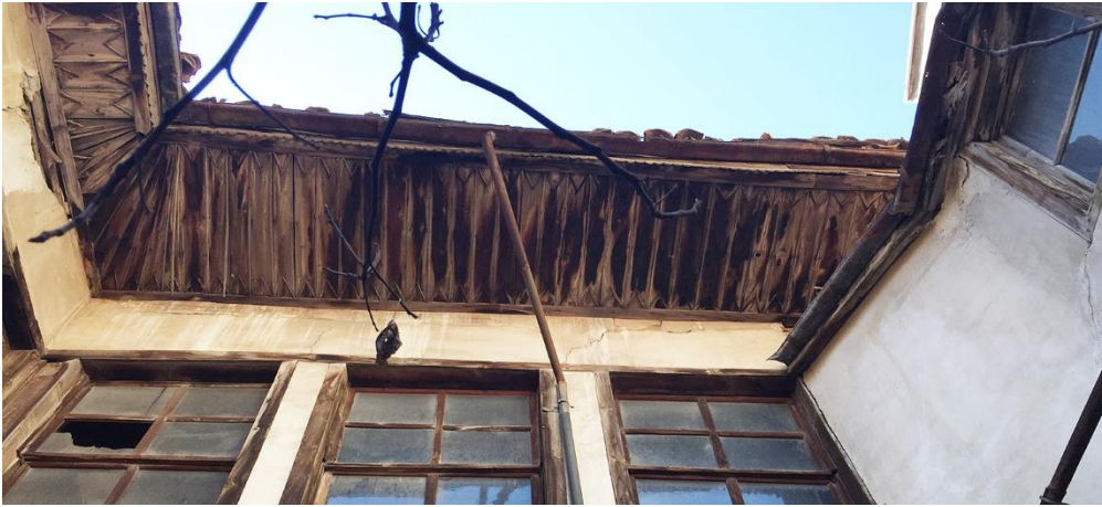
Şekil 21. Kuzey cephesi saçak altı bezemesi (Kaynak: Esra Büyükemir Karagöz kişisel arşivi).
