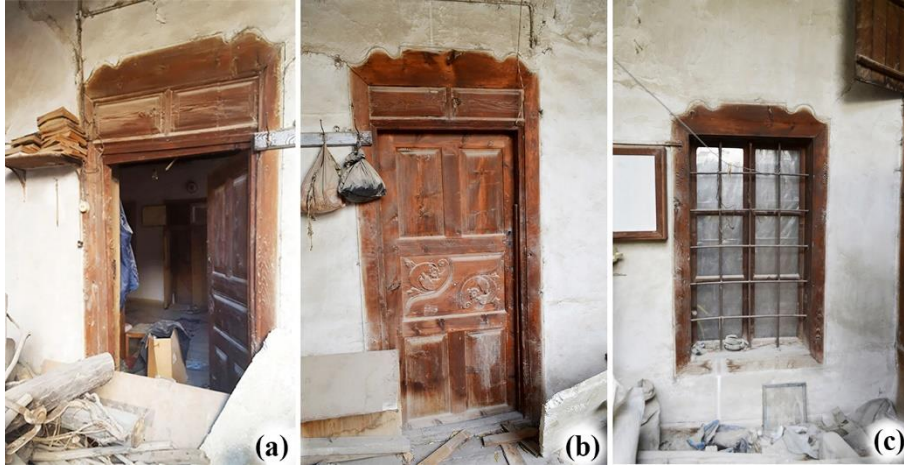
Şekil 6. (a) Z1 oda kapısı; (b) Z2 oda kapısı; (c) Z2 odası kuzey penceresi (Kaynak: Esra Büyükemir Karagöz kişisel arşivi).
