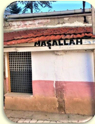
Şekil 2. Kümese Duvarında "Maşallah" Yazısı K16
