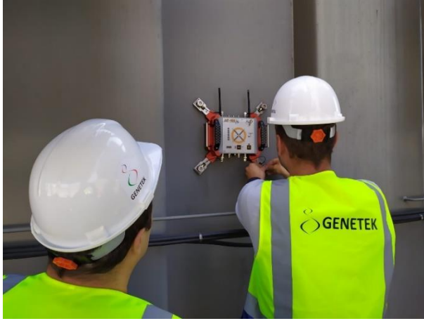
Şekil 10. Güç transformatörlerinde yüzey temaslı akustik sensörler ile kısmi deşarj ölçümü (Partial discharge measurement using acoustic sensor in power transformer)
