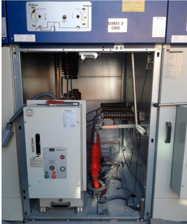
Şekil 5. Güç kablolarında yüksek frekanslı akım transformatörü ile kısmi deşarj ölçümü (Partial discharge measurement using high frequency current transformer in power cables)
