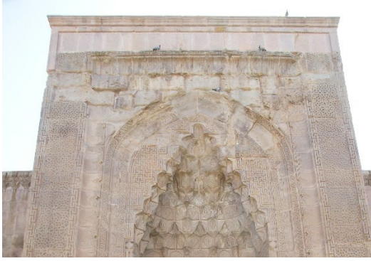
Görsel 3. Kayseri Sultan Hanı Kapalı Kısım Taçkapısı
