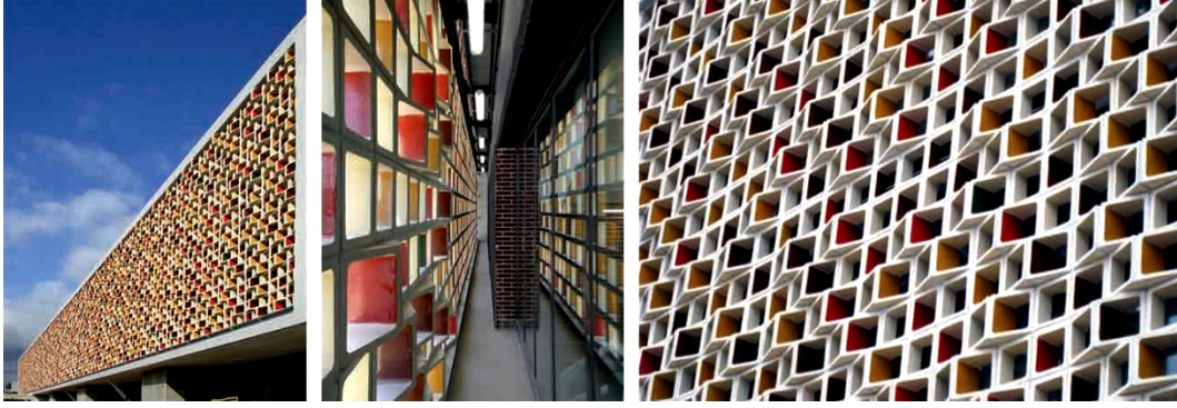
Resim 18. Dış Cephesi Seramik Modüllerle Kaplanan Martinet İlkokul Binası, Barselona, İspanya (URL-16)
