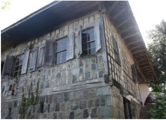
Kuzey cephesi görünüşü
