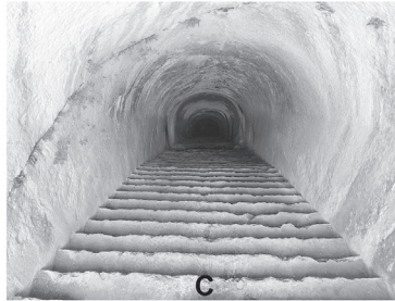
Levha 2. At Nalı Formlu Basamaklı Tünellerden Bazı Örnekler. A- Gökçeli Kalesi Basamaklı Tüneli (A. E. Bulut), B-Turhal Kalesi Basamaklı Tüneli (A. E. Bulut), C- Çekerek Basamaklı Tüneli (A. E. Bulut).
