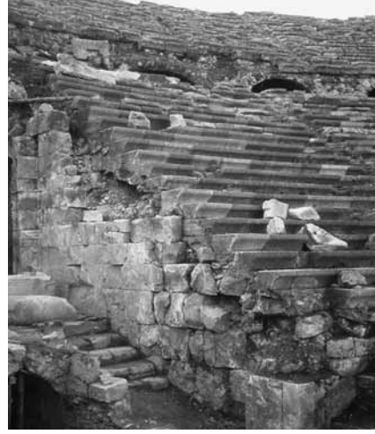
Res. 15 Analemma Duvarında Bozulmalar
