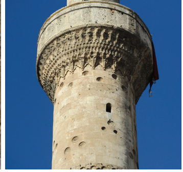
Fot. 18: Hızanoğlu Cami Minarede Dökülmüş Bacini Yuvaları
