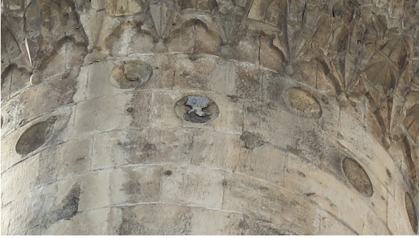
Fot. 17: Hızanoğlu Cami Kırık Bacini Detayı
