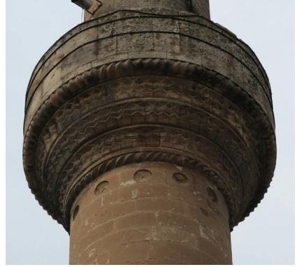
Fot. 20: Hayrullah Cami Minare Şerefe Altındaki Boş Bacini Yuvaları
