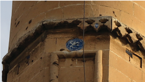
Fot. 15: Yusuf Paşa Cami Minaresinde Bacini Detayı
