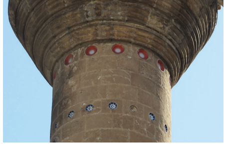
Fot. 4: Mevlid-i Halil Cami Minare Şerefe Altındaki Baciniler
