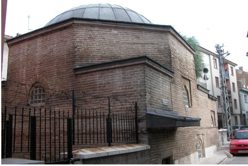
Fotoğraf 6. Kuzey batı cephesi
