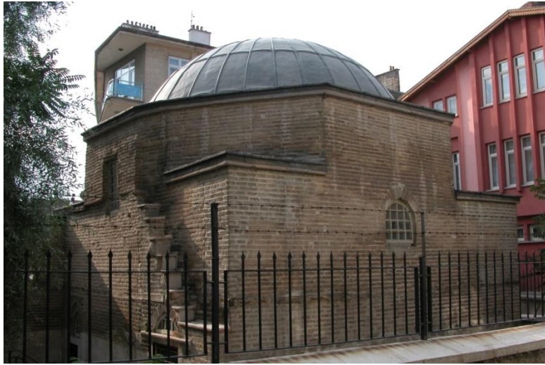
Fotoğraf 5. G ney dođu cephesi
