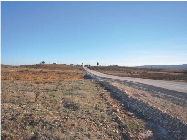
Fig. 18: Ayanlar Höyük, View from North / Ayanlar Höyüğü, Kuzyeyden Görünüm (Photo by B. Çelik).
