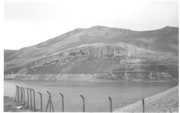
Şekil 5. Güzelsu Barajında Ziyaret kireçtaşında gelişen karstlaşma
