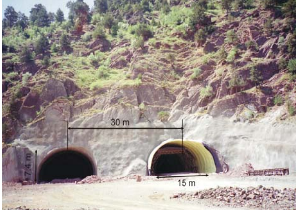
Şekil 6: Kırkgeçit-1 tünelinin saha görünümü.
