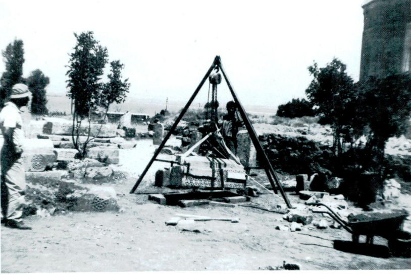
Resim 20 — Restorasyon çalışmalarından bir görünüm.
