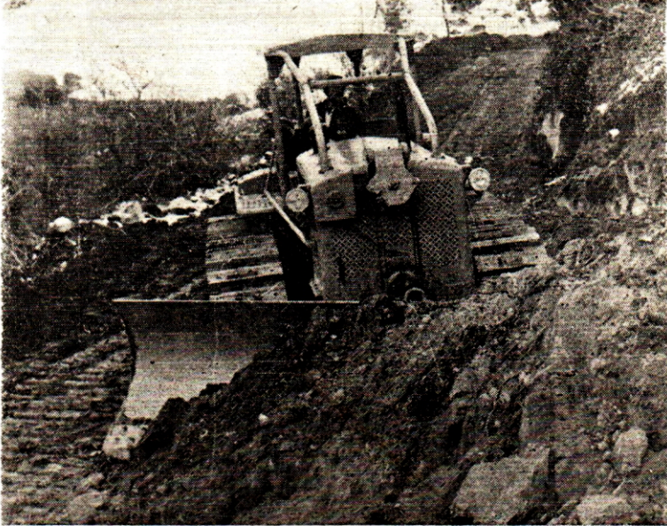
Şekil 12 — Orman Yolu inşaatında çalışan bir buldozer
