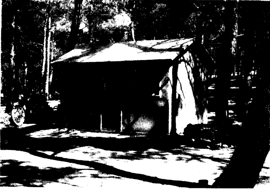
Resim 2 — Reçine elde etme denemeleri sahasının kontrolü ve âletlerin muhafazasında kullanılan kulübe. Foto: A. Berkel
