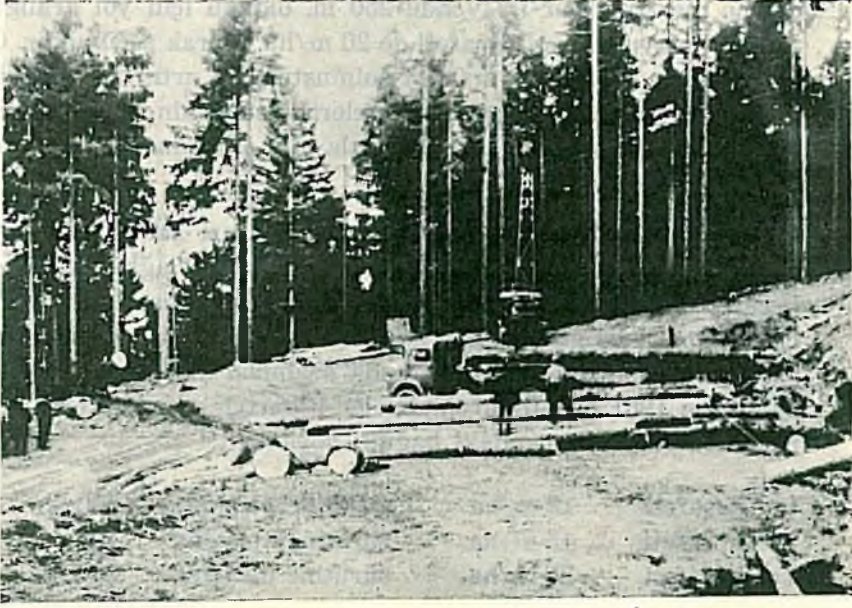
Şekil 15. Kısa mesafeli Göss vinçli hava hattı (Foto. Bayoğlu)
