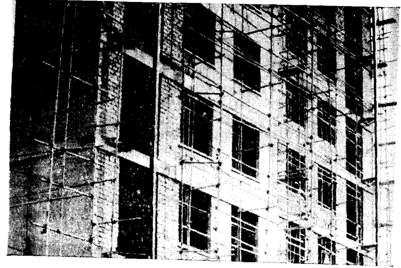
Resim 14: 1-1,5 parmak çapındaki yuvarlak kesitli demir boruların özel bağlantılarla meydana getirdiği dış iskeleler
