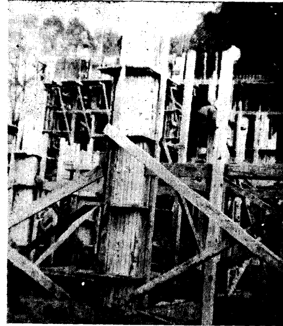
Resim 1: Biçilmiş ağaç malzemenin hiçbir tasarruf gözetilmeden yuvarlak kesitli kolonlarda kalıp kerestesi olarak kullanılması
