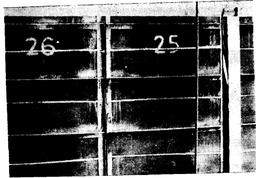
Resim 5: Düz döşeme ve duvarlarda yağlanarak müteaddit defalar kullanılan özel lif levhalarının arkadan takviyesi
