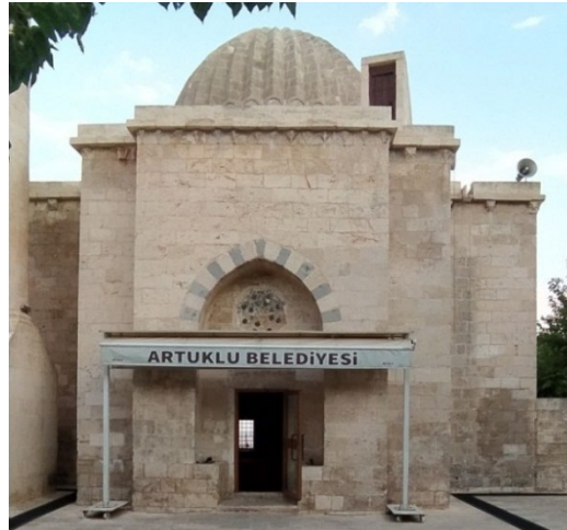
Şekil 7. Sultan Hamza-i Kebir Camii'nin kuzey cephesi
