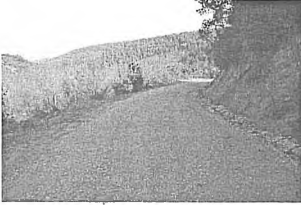
Figure 5. A view from the forest road after pavement activity (Photo: T.Ozturk) Şekil 5. Üstyapı çalışmasından sonra orman yolundan bir görünüş
