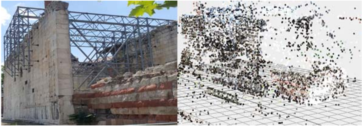
Şekil 9. Ön duvarın fotoğrafı ve tapınağın aynı açıdan nokta bulutu (Photograph of the front wall and point cloud of the temple from the same angle)
