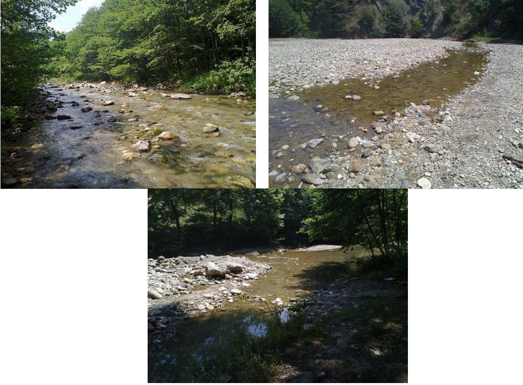
Resim 1. Bursa ili civarındaki bir nehir tipi hidroelektrik santralinin su alım noktasından daha yukarıdaki (membra) bir akarsu kesiti (sol üst resim), Santralin akarsudan su aldığı kısım ile suyu geri verdiği kısım arasındaki ara segment (sağ üst resim), Santralin kuyruk suyunu verdikten sonraki aşağı (mansap) akarsu kesiti (alt resim) (Resim: İ.Yurtseven)
