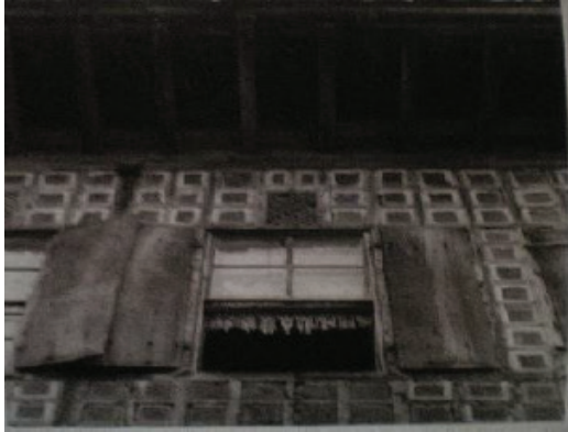
Şekil 18. Türk evinde tepe penceresinin en küçük formu ve ahşap kapaklı sürme pencere örneği, (Küçükerman, 2007).
