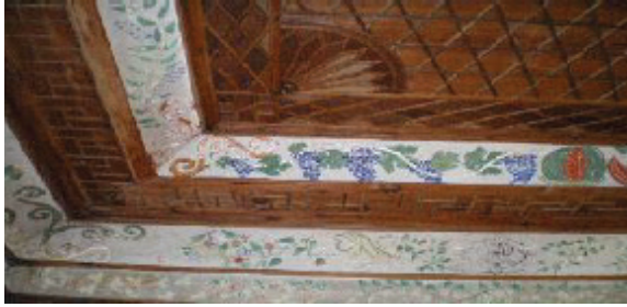
Şekil 21. Özenli bir yapıda kalem işi tekniğiyle yapılmış bir tavan örneği, Safranbolu (Bozkurt, 2009).
