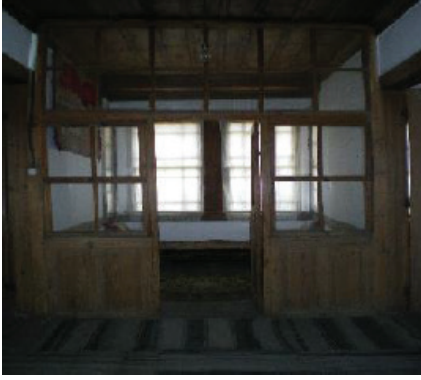
Şekil 26. Türk evinde odalar arası eyvanın kapatılarak odaya dönüştürüldüğü bir örnek, Safranbolu (Bozkurt, 2009).
