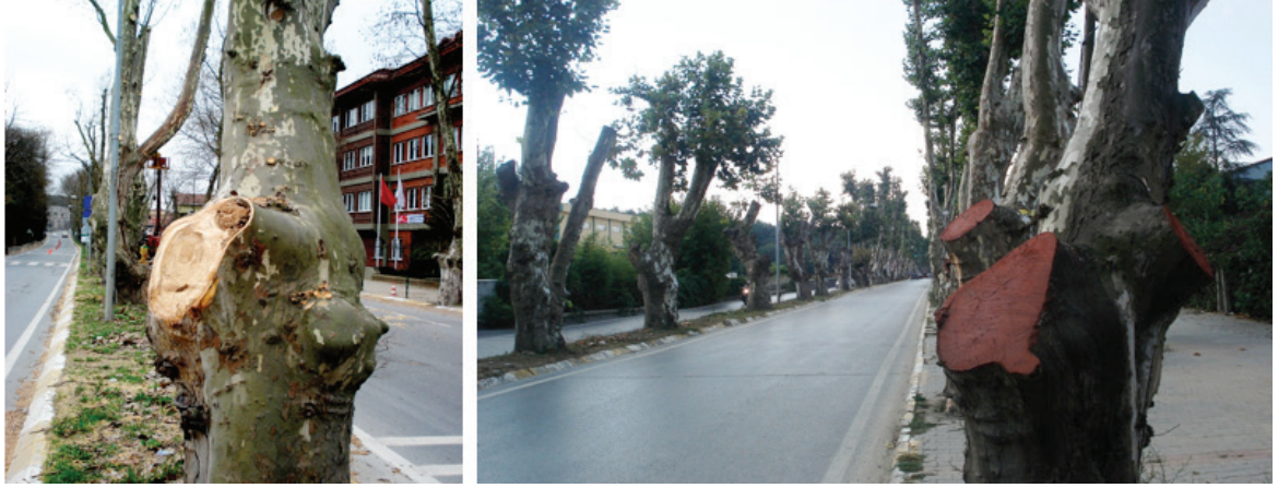
Şekil 12. Budama sonucunda oluşan yara yüzeyleri koruma macunu ile kapatılmıştır. Figure 12. Cutting surfaces were covered with protective materials.
