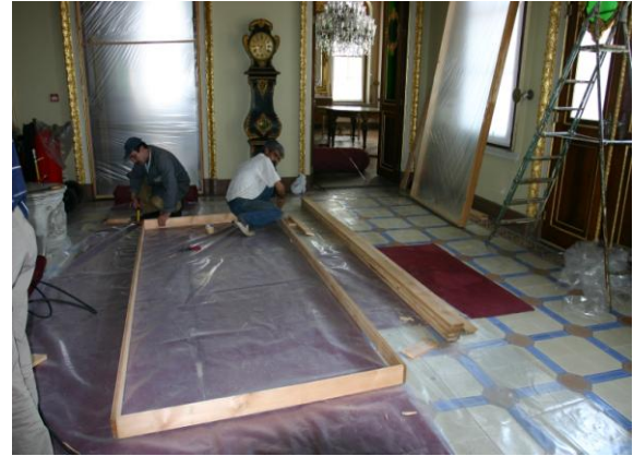
Şekil 4. Kasrın içinde yapılan izolasyon çalışmaları (MS Arşivi).
