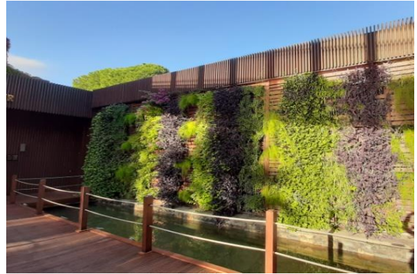
Şekil 10. Dış mekândaki yeşil cephenin yenileme sonrası görünümü (Orijinal, 2020)
