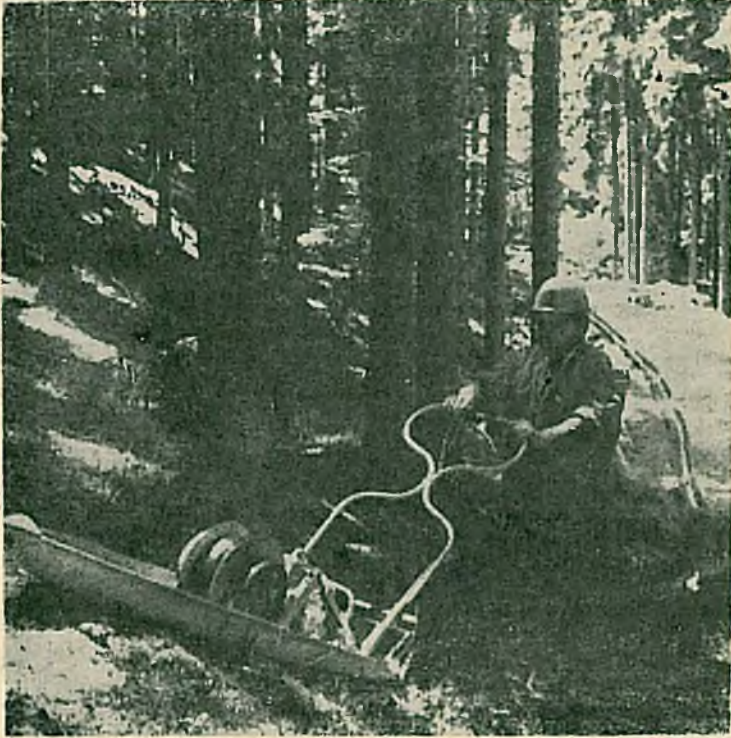
Şekil 10: ACKJA - kablolu vinç vardımı ile plastik kanalların belirli bir meyille bölmeye çıkarılışı.
