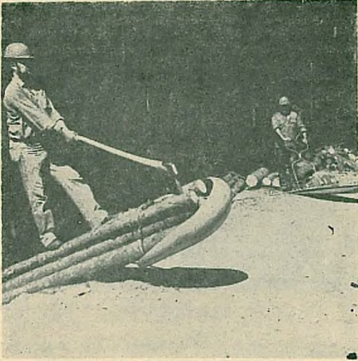
Şekil 7: ACKJA - kablolu vincinin iki işçi tarafından çalıştırılması.
