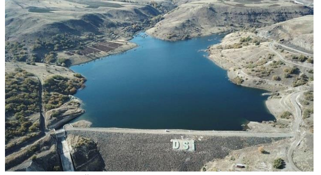
Şekil 1. Baraj Üst Görüntüsü [9].
