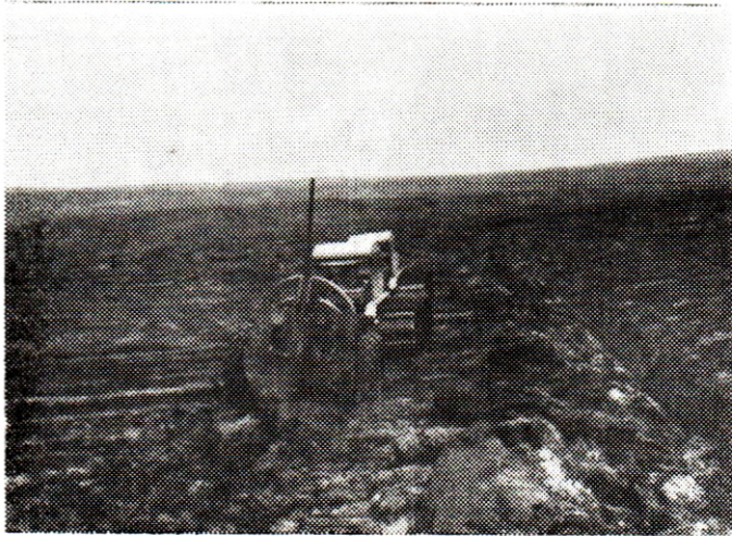
Resim 4. Islak ağaçlandırma sahalarında drenaj hendeklerinin açılması. Kielder ormanı kuzey İngiltere. 1965. İ. Atay.
