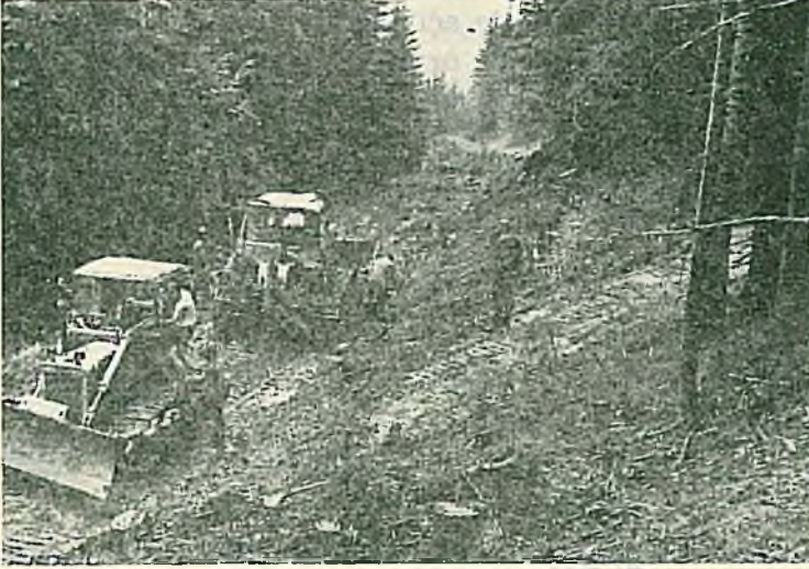
Resim 3 : Bir orman şosesinin açılmasında, önde büyük (160 PS), arkada küçük (65 PS) iki buldozerin beraber çalışması. Büyük makine kaba olarak yolu açıyor. küçük makine ince tesviyeyi yapıyor ve şevleri tıraş ediyor (Foto: Tavşanoğlu)
