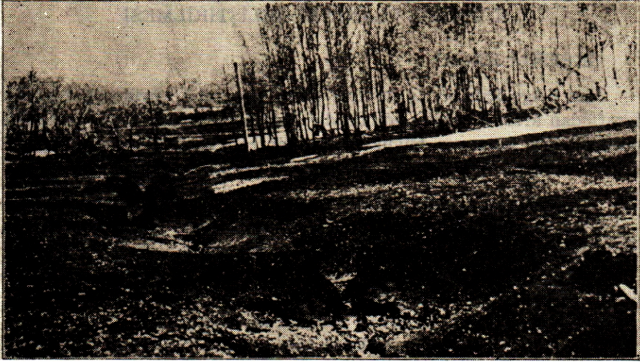
Resim 7 — Kar sularının tahrip ettiği hendekler. Bu tahrip, hendeklerin dikkatli yapılmasıyla önenebilir.
