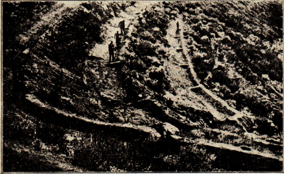
Resim 2 — Yatay hendekli terasların tamamlanmasında çalışan işçiler. Tesviye eğrilerine paralel hendekler, ayırma setleri vasıtasıyla çok sayıda depolama ünitelerine bölünür.
