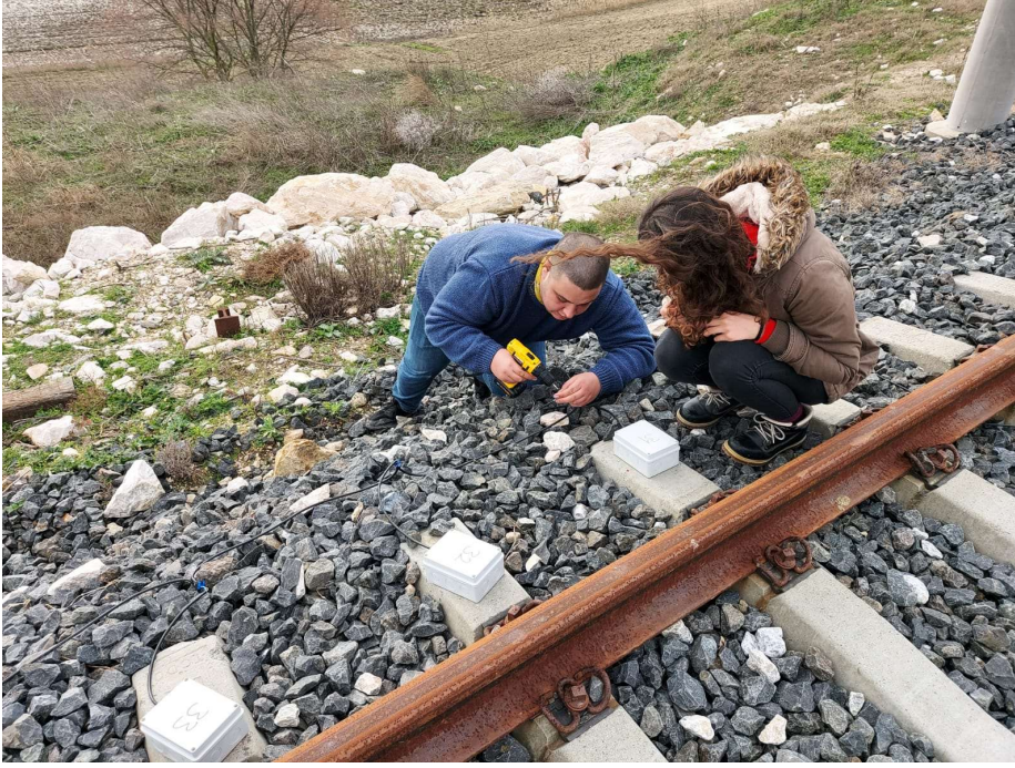
Şekil 4. Sistem kablo bağlantılarının yapılması.
