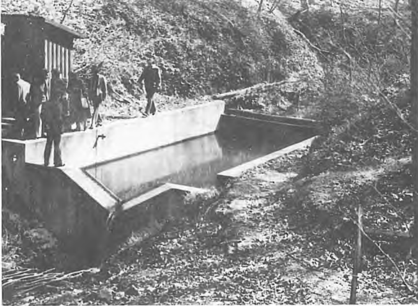
Şekil 2 : IV no'lu havzada kurulmuş bulunan 120^\circ\text{C} 'lik, V kesitli ve keskin kenarlı akım ölçme istasyonu.
