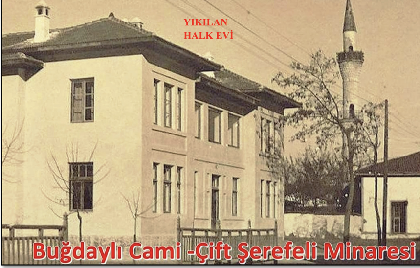
G. 10: Yıkılan Buğdaylı Camii ve yıkılan Uşak Halk Evi binası (Alp Arslan Dur arşivi)
