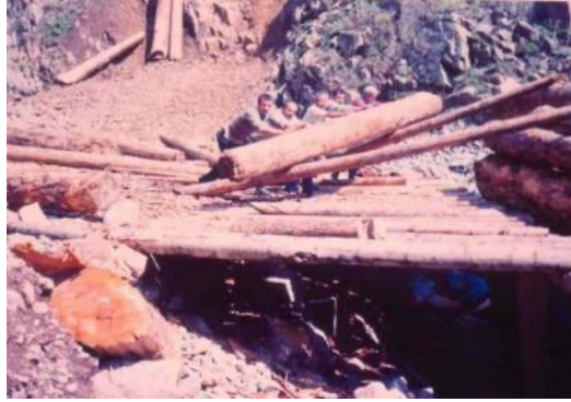
Şekil 1. Rampadan yükleme Figure 1. Loading ramp
