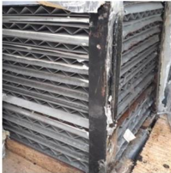
Şekil 5. Isı geri kazanım ünitesi (Heat recovery unit)
