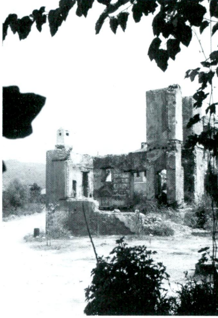
Res. 7 – Kaya Köy-yol kenarında bir Rum konutu.
