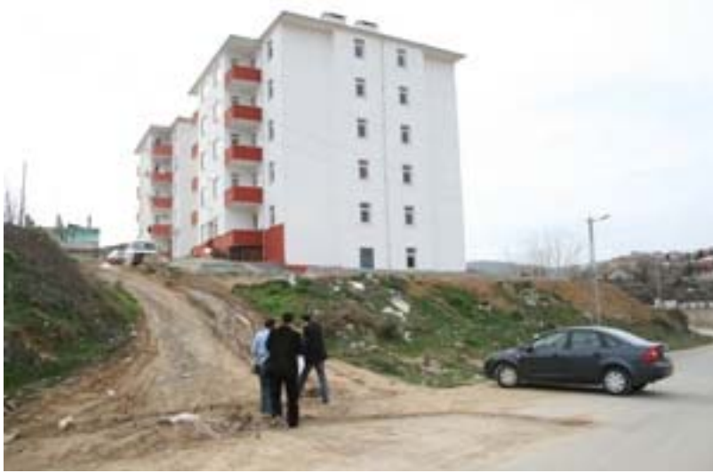
Resim 5. Sosyal konutlar, Velibaba'daki konutlardan farklı olarak site tarzında yapılmıştır. Ancak altyapı ve diğer sorunlar burada devam etmektedir. Resimde de görüldüğü üzere binaların yolları dahi henüz tamamlanamamıştır.
