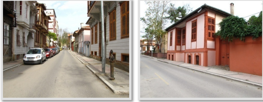
Şekil 4. Maarif Caddesi'nde restore edilmiş tarihi yapılara ilişkin görünüm (Orijinal, 2012)
