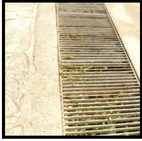
Şekil 7. Döşeme bozulmaları ve drenaj ızgaraları. (Orijinal, 2011) Figure 7. Pavement corrosion and drainage loopholes
