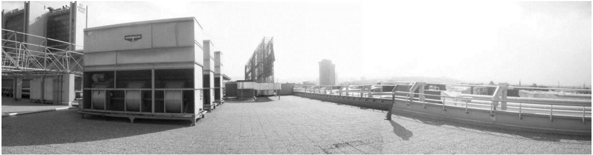
Şekil 9. Binanın çatı konstrüksiyon materyallerinden görüntüler. Figure9. An image of rooftop construction materials of the building.
