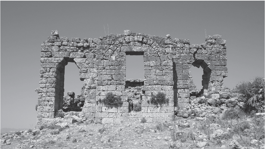
Fig. 14 Hamamın güney cephesi.
