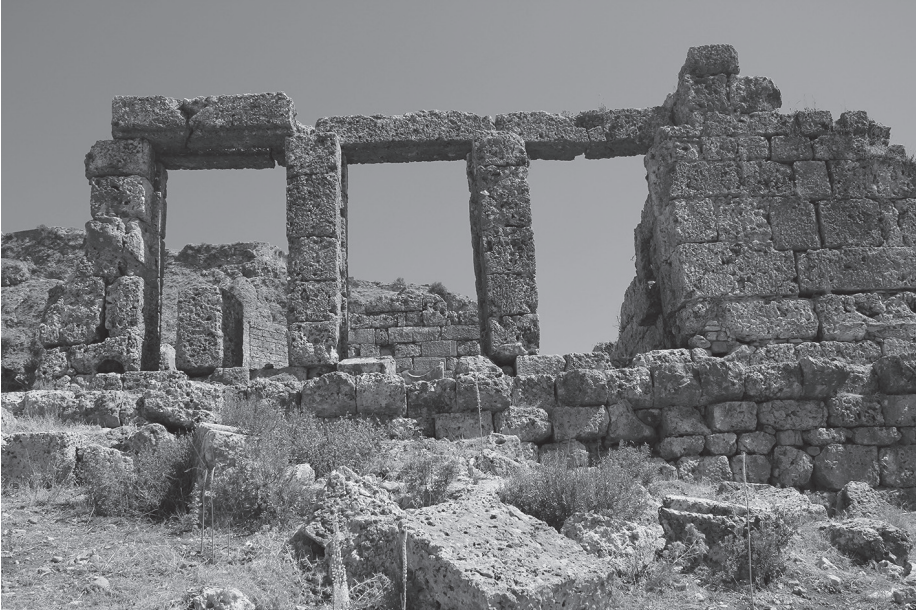
Fig. 12 Batı cephedeki in situ pencere.
