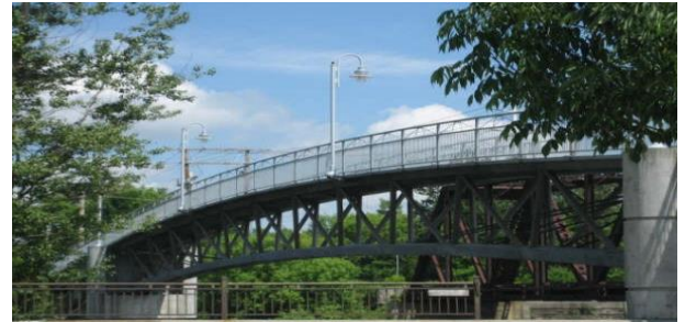
Şekil 11. RPB ile Üretilen Sherbrooke Köprüsü (Gilliland, 1996).
