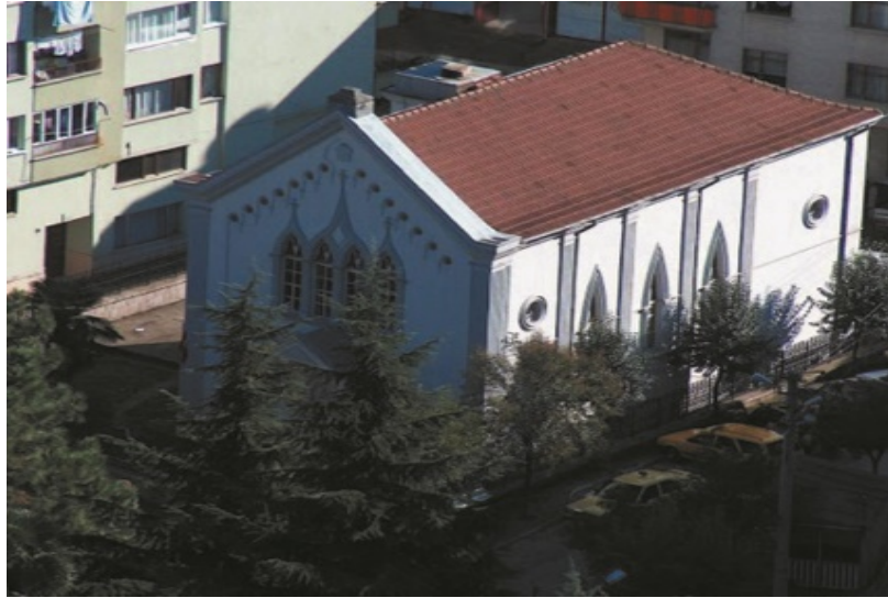
Resim 16 Giresun Merkez Çocuk Kütüphanesi dış cephe görünümü (URL 20)
