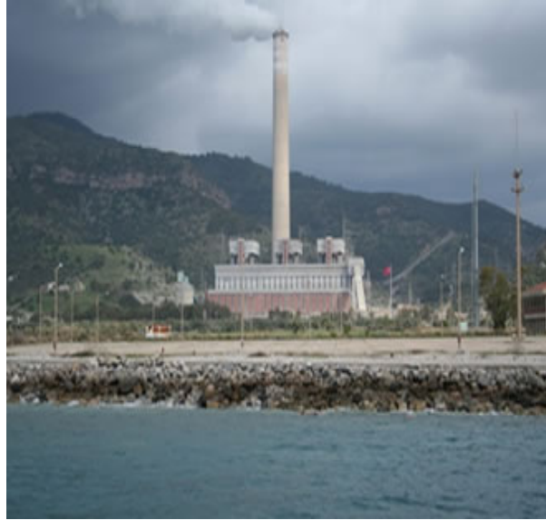
Şekil 3.2: Kemerköy Termik Santrali
