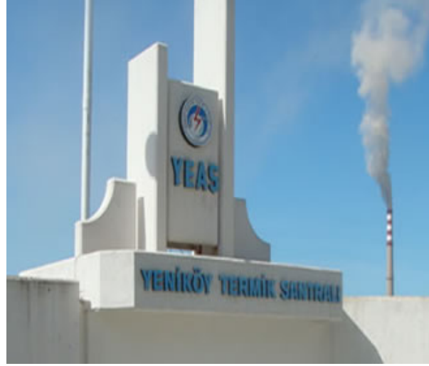
Şekil 3.3: Yeniköy Termik Santrali
