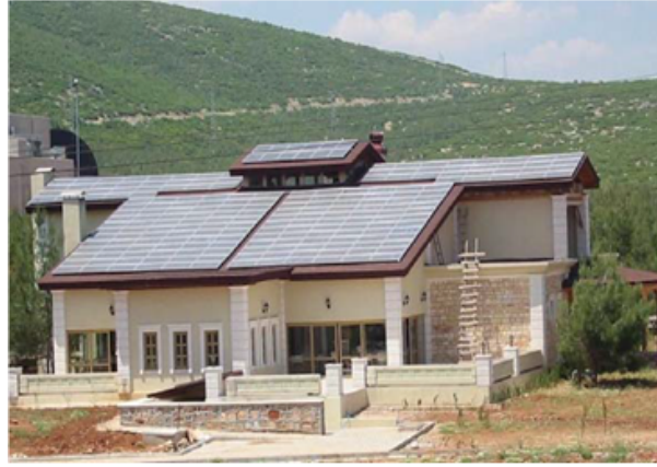
Şekil 2.2: Muğla Üniversitesi Türk Evi çatısı üzerindeki fotovoltaik sistem
