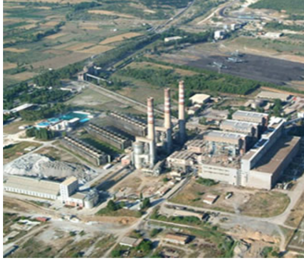
Şekil 3.1: Yatağan Termik Santrali
