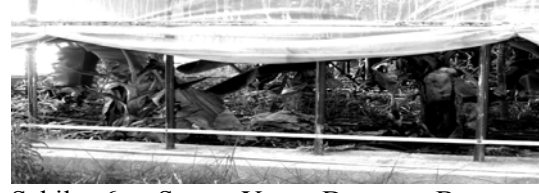
Şekil 6. Sera Yan Duvarı Boyunca Merteklerin 75 cm Ara İle Yerleştirildiği Örnek Bir Sera
