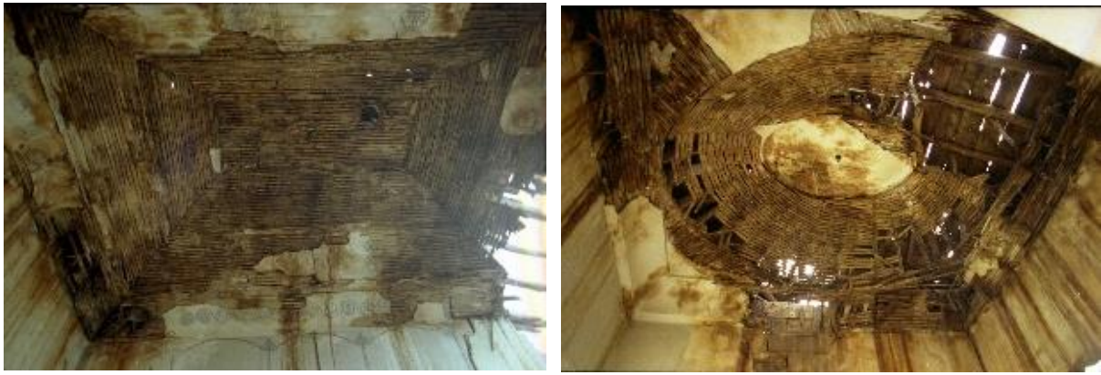
Şekil 5. a, b. Bağdadi tekniğinde yapılan dörtgen ve elips tekne tavanlar - Akyüzler Evi [18]
