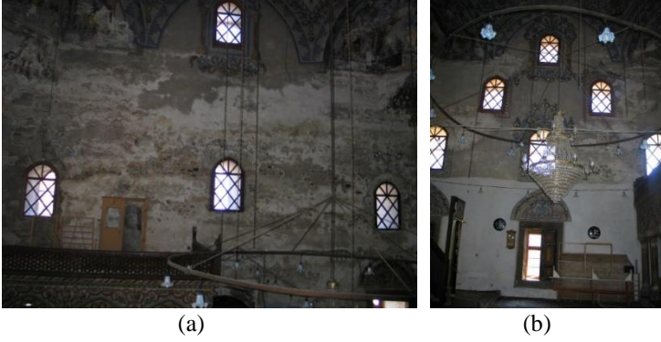
Resim 7. a. Kuzey cephe b. Batı cephe sıva ve bezemeler (Sevgi, 2006)
